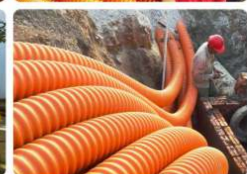
Dự án Khu Công nghiệp Nghị Sơn (Thanh Hóa)
