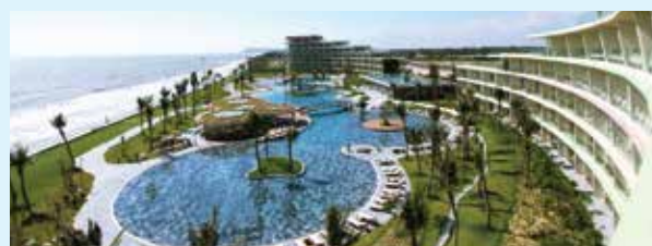
Dự án: Quần thể Sân Golf, Resort, Biệt thự nghỉ dưỡng và giải trí cao cấp FLC Quy Nhơn, Bình Định Project: FLC Quy Nhon Beach & Golf Resort in Binh Dinh
